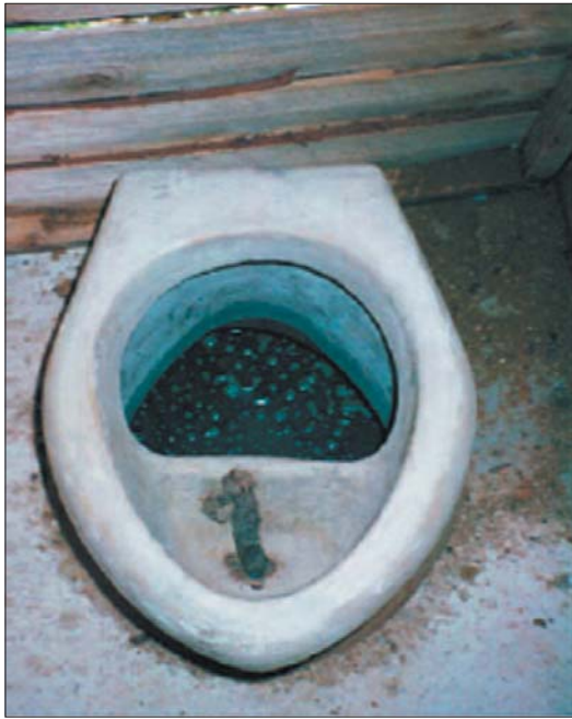
Figure 2. La contamination fécale croisée de l'urine constitue le principal risque sanitaire lors des manipulations ultérieures de cette fraction. La toilette doit être adaptée à l'utilisateur et au contexte. Un siège de toilette peut présenter plus de risque si la population est habituée à la position accroupie. Le siège lui-même doit être adapté à l'utilisateur. Dans des écoles, une zone trop large de collecte de l'urine peut être la cause de problèmes de mauvais placement des matières fécales.
